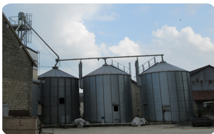
Installation extérieure de M. TASSOT
